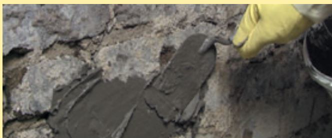
3. Wlać w otwory Zaprawę uszczelniającą Ultrament .
