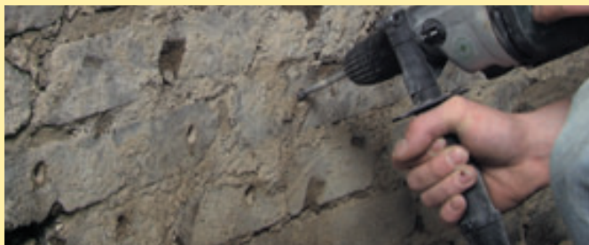
1. Wykonać otwory w ścianie.
